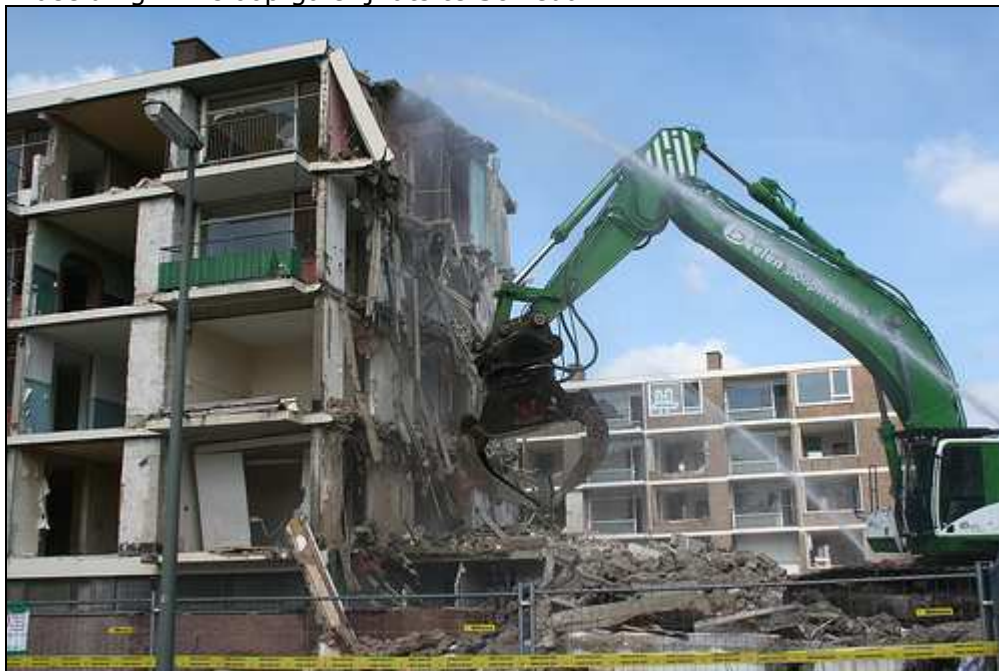
Afbeelding 21: sloop galerijflats te Schiedam
