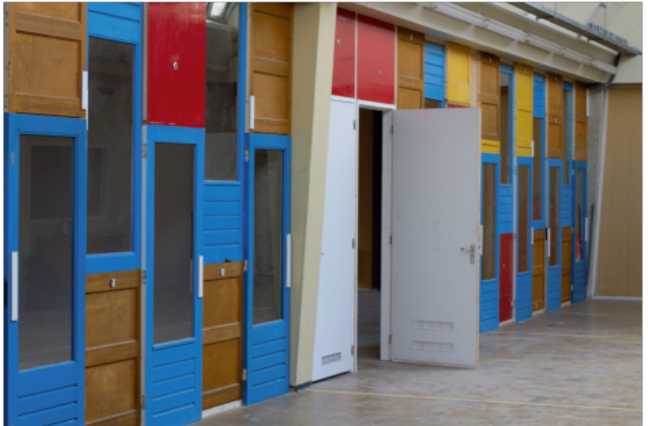
Afbeelding 4.3: Hergebruikte deuren in wanden (Credits: Hein Lagerweij)
