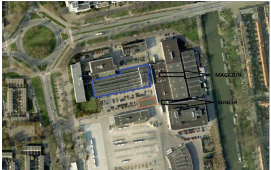
Afbeelding 4.2: Luchtfoto Magazijn en Bunker, VechtclubXL
