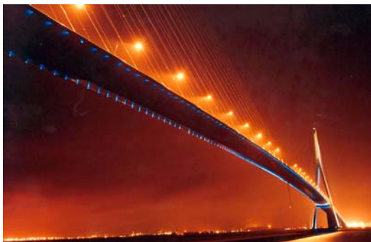
Fig. 18 Yann Kersalé, Pont de Normandie, 1994.
